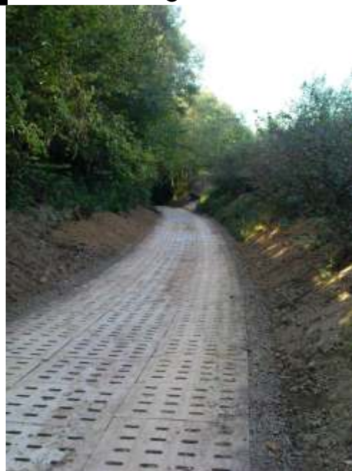
Droga Zdziłowice Drugie - Popławy po remoncie.
