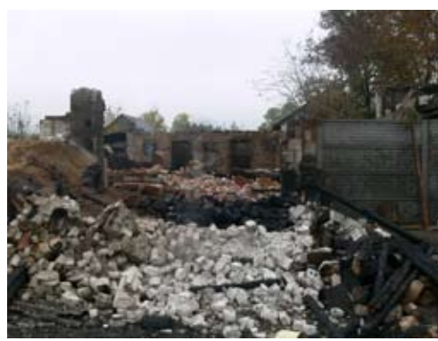
Zniszczenia jakie spowodował ogień w gospodarstwie Tadeusza Krzysztonia
