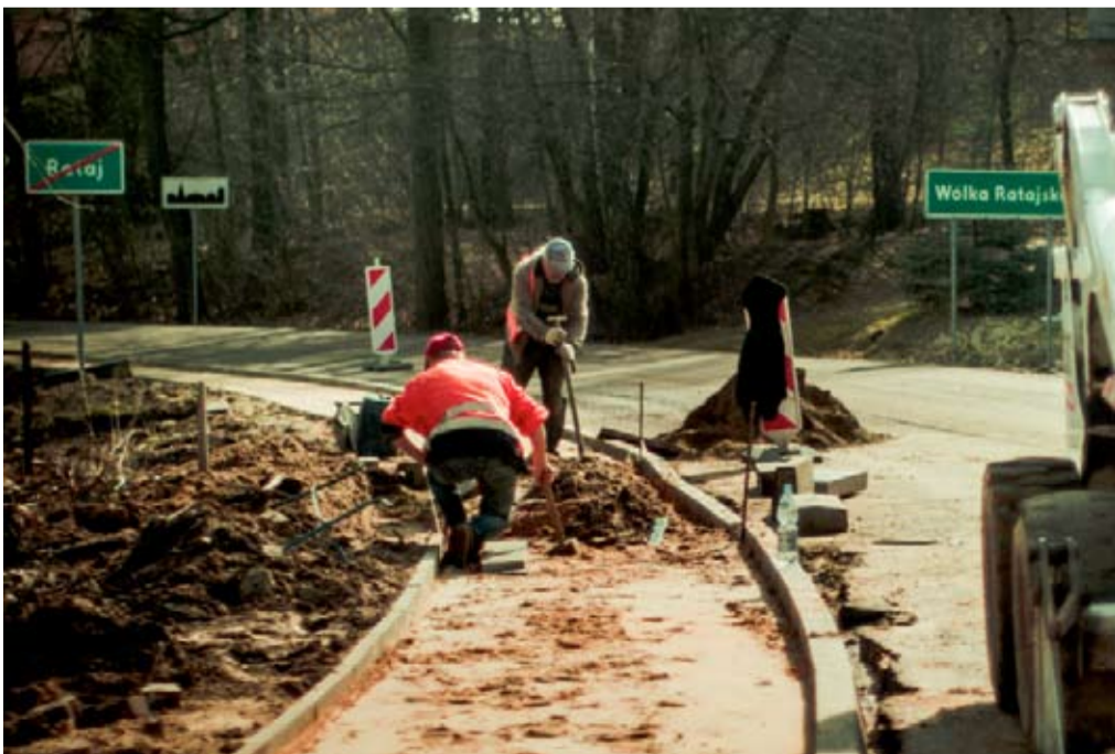
Na zdjęciu prace przy przebudowie chodnika w Rataju. Fot. Robert Radzik
