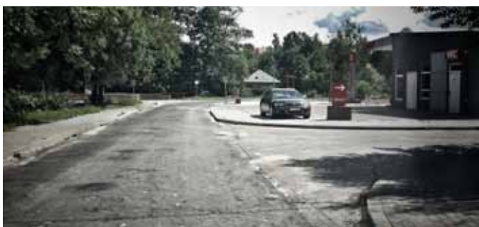
Początkowy odcinek przebudowy drogi gminnej
